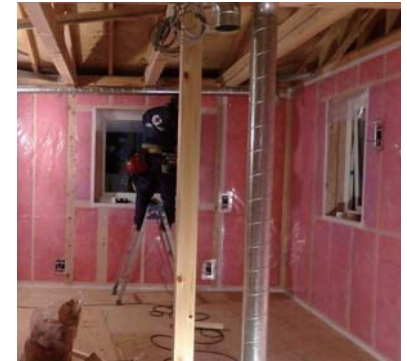
グラスウールによる充填で断熱の施工
